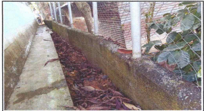
Foto 4: SE OBSERVA LA SUSTITUCION DEL MURO PERIMETRRAL
